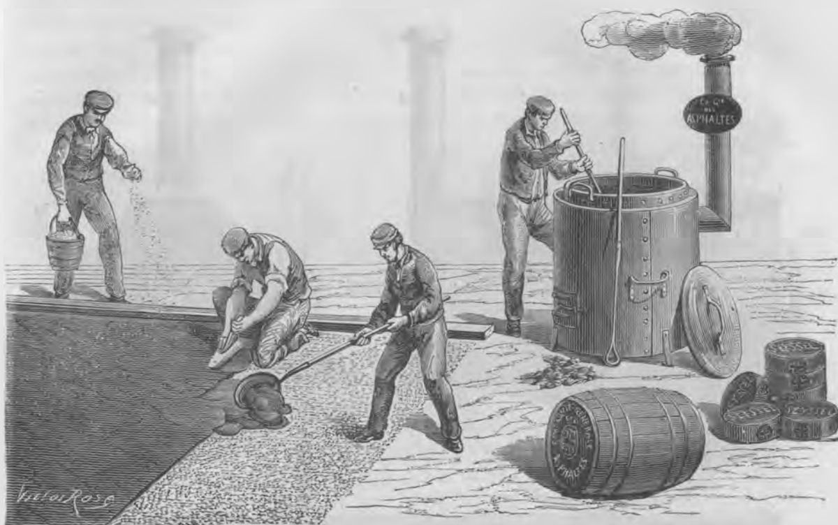
Fig. 284. — Ancienne chaudière pour l'application de l' asphalte coulé , et pavage d'un trottoir en asphalte coulé .
