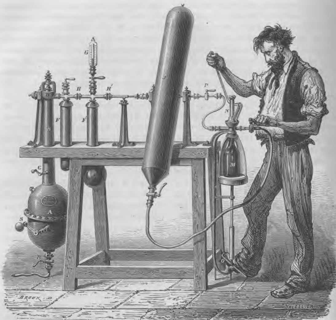
Fig. 176. — Appareil de Savaresse à cylindre oscillant.
