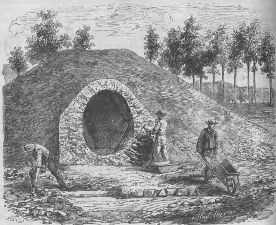
Fig. 151. — Section de l'aqueduc de la Dhuis.
