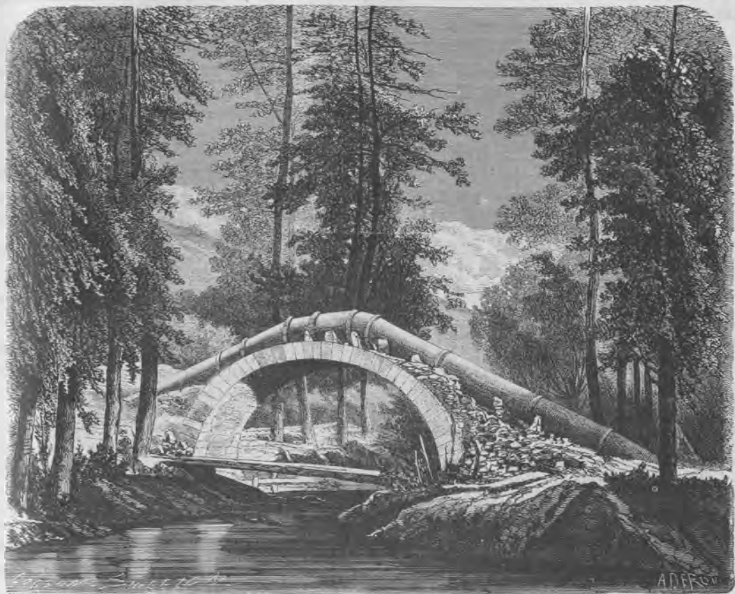
Fig. 152. — Un des ponts-siphons de l'aqueduc de la Dhuis.
