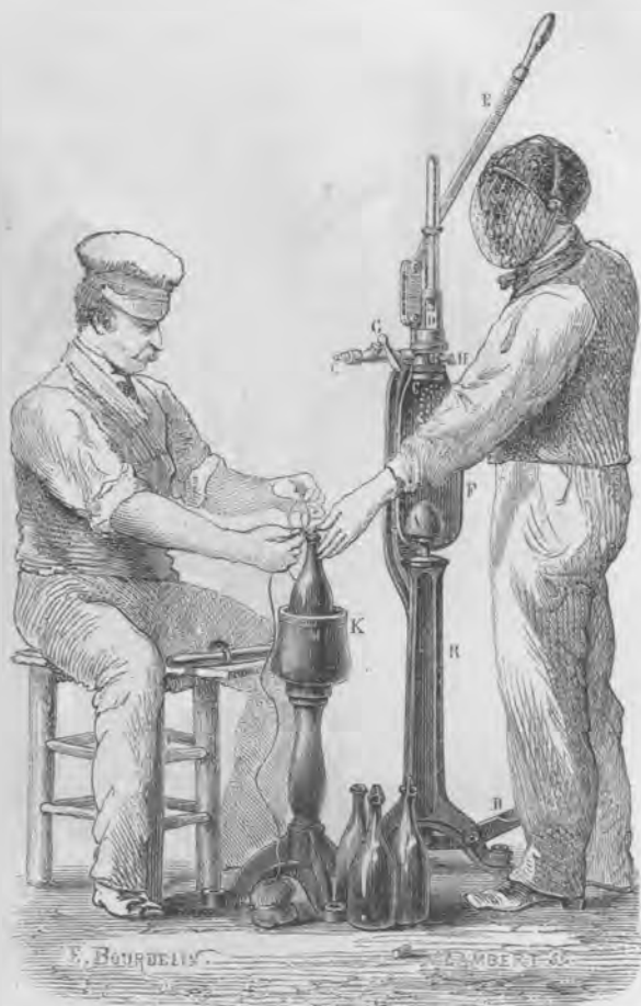
Fig. 192. — Ficelage du bouchon.
